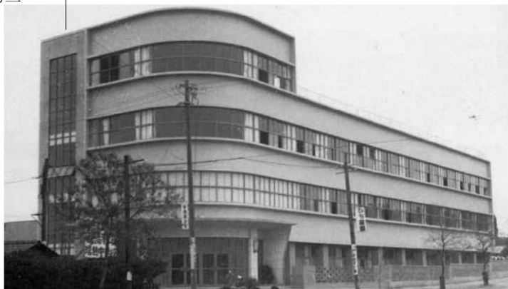
鉄筋コンクリート造の1号館
