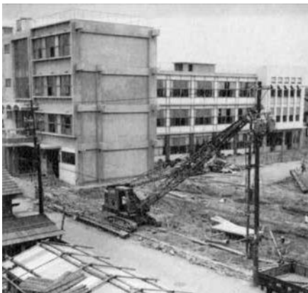
建設中の3号館
