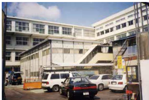
校庭に建てられた仮設のプレハブ校舎
