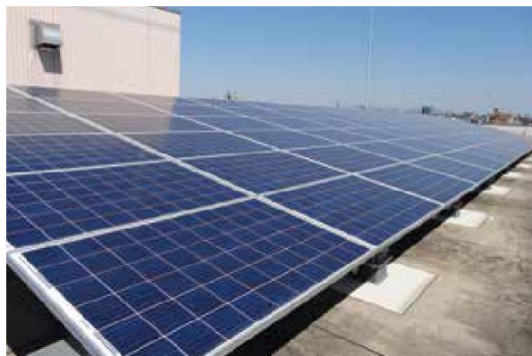
屋上に設置したソーラー発電システム
